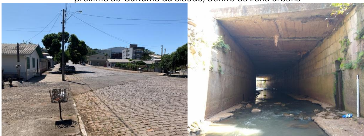
Figura 81 – Galeria fechada por onde passa o Arroio Barracão, estrutura localizada próximo ao Curtume da cidade, dentro da zona urbana
