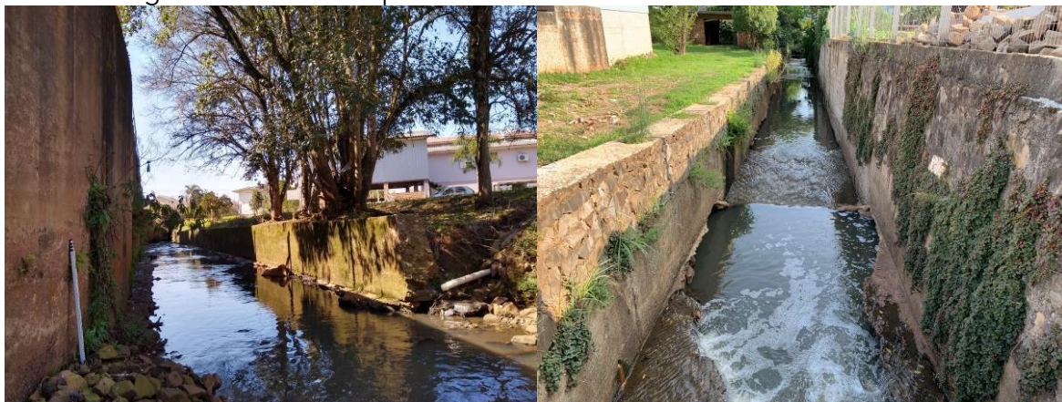
Figura 82 - Canais impermeabilizados localizado no Arroio Barracão
