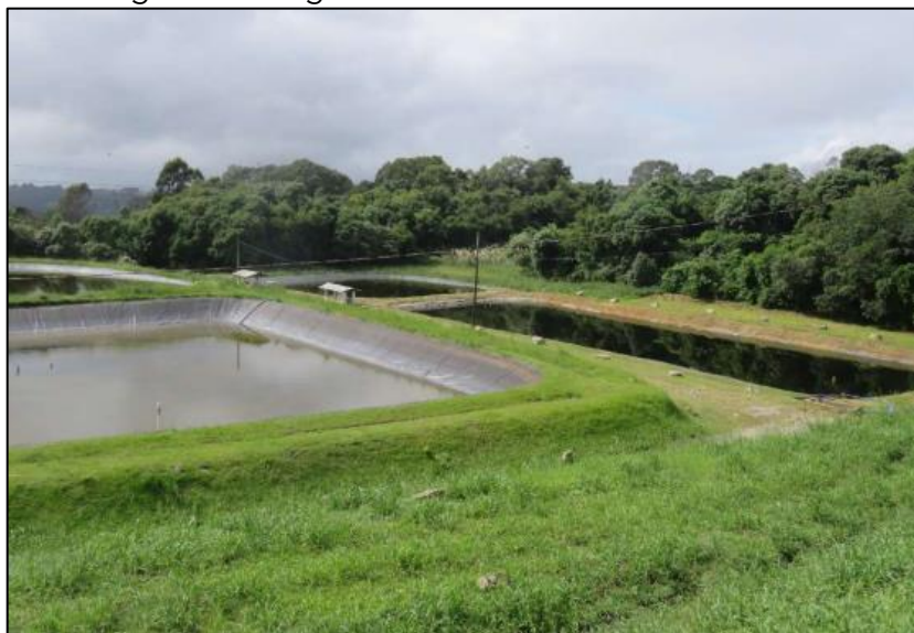
Figura 51 - Lagoa de acúmulo de efluente
