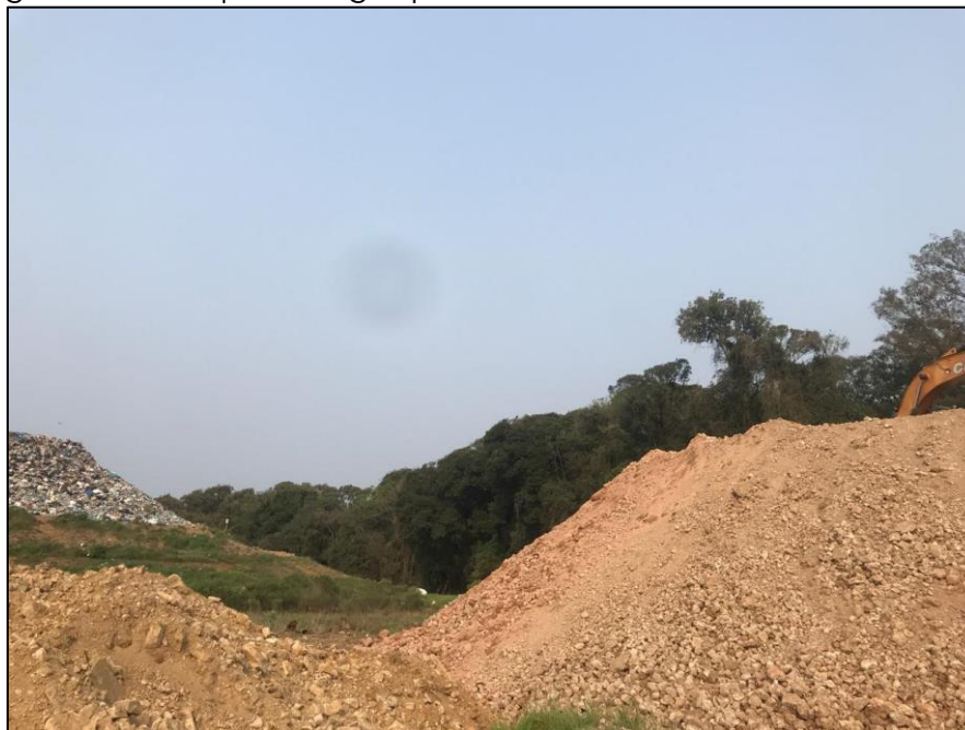
Figura 57 - Estoque de argila para recobrimento dos resíduos
