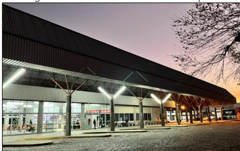
Figura 82 - Terminal Rodoviário de Farroupilha
