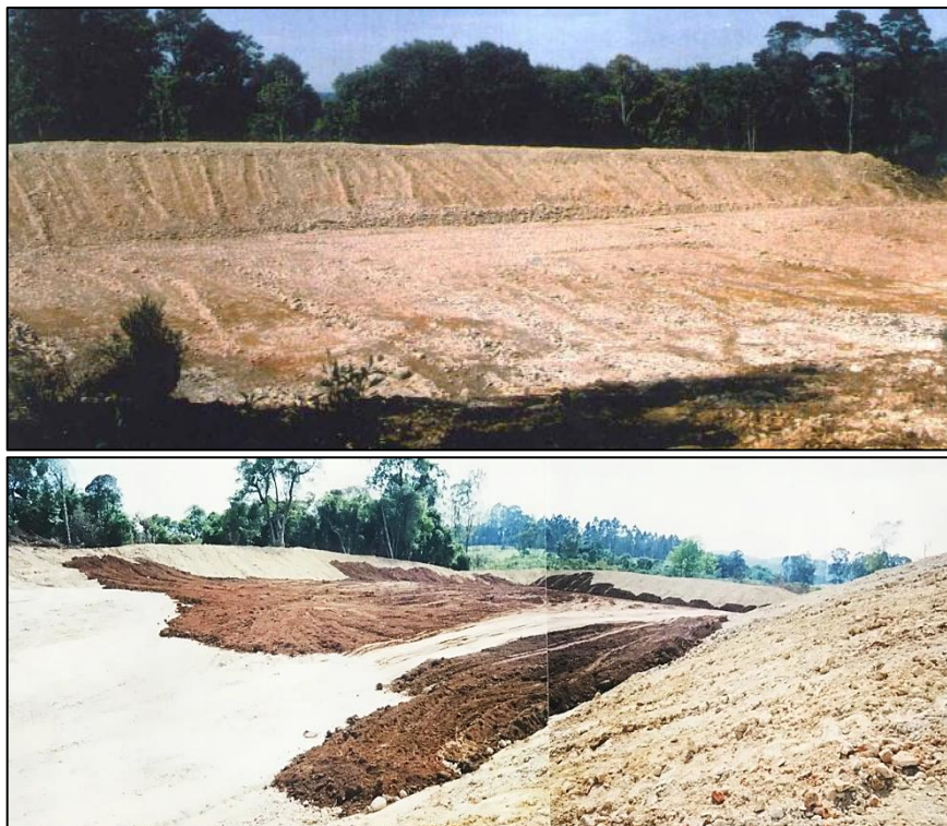
Figura 28 – Início da obra do aterro sanitário
