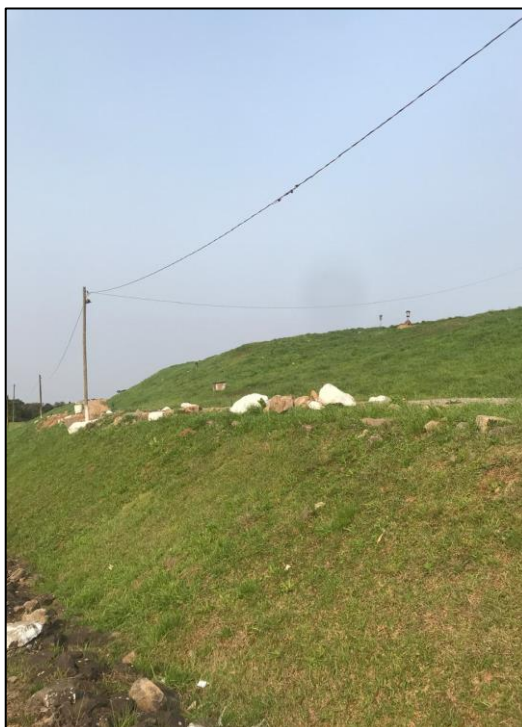
Figura 49 - Células encerradas do aterro sanitário de Farroupilha
