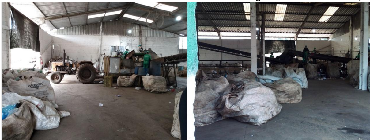
Figura 15 - Esteira de Triagem, trator para transporte do resíduo orgânico e bags de acondicionamento dos materiais recicláveis - Reciclagem ADEVA/Nova Araçá
