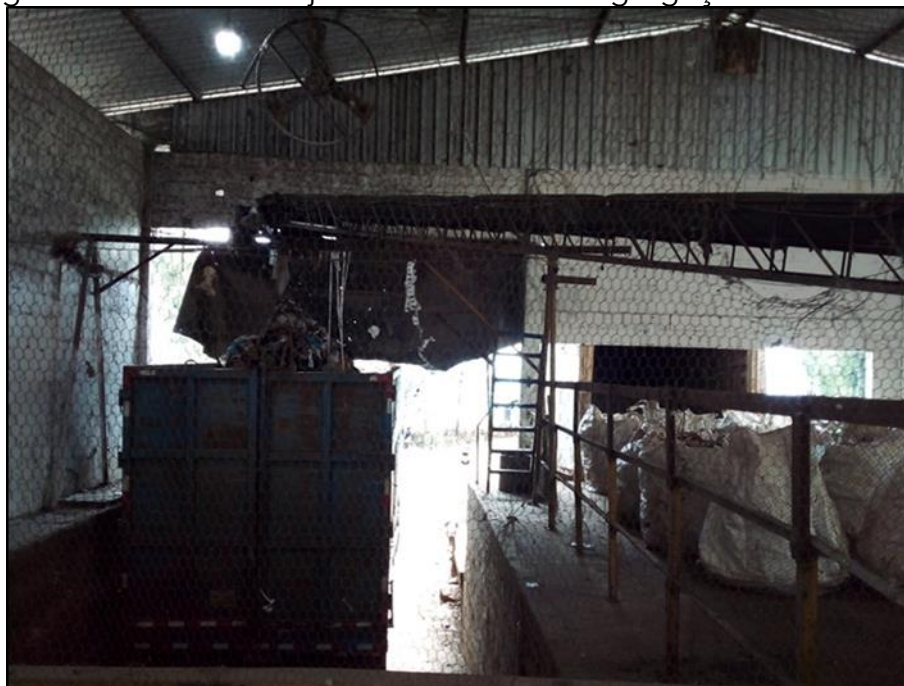
Figura 16 - Saída de rejeito da esteira de segregação - Nova Araçá
