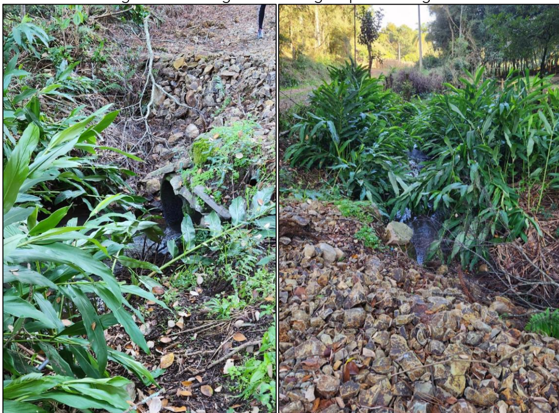
Figura 63 – Deságue da drenagem próximo à gruta
