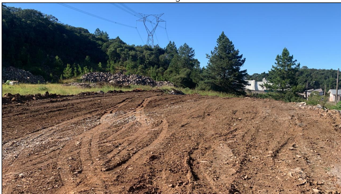
Figura 22 – Área utilizada como aterro dos resíduos do serviço de limpeza e estrutura de drenagem
